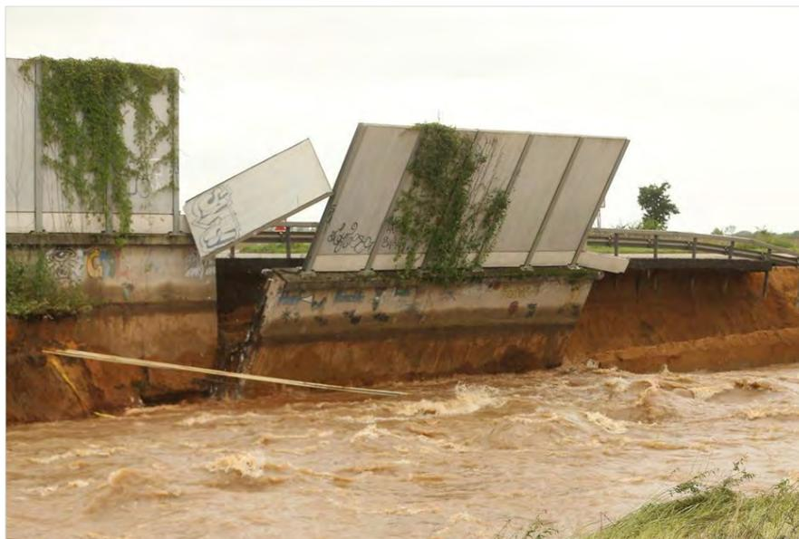
Figure 3.45. Failure of noise barrier wall, captured on video, Source: <https://www.welt.de/vermischtes/article232546283/Hochwasser-in-Erfstadt- Standstreifen-der-A1-bricht-ab-und-stuerzt-in-die-Erft.html>
