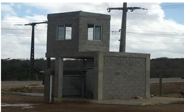
Figura 4 - Presença de guarita na entrada do ASCG
