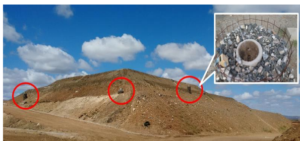
Figura 10 - Dreno vertical de biogás em uma célula de resíduos no ASCG
