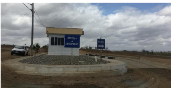
Figura 5 - Balança para pesagem dos resíduos que são recebidos no ASCG
