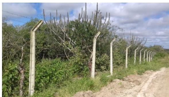
Figura 3 - Isolamento da área do ASCG com cercas de arame farpado
