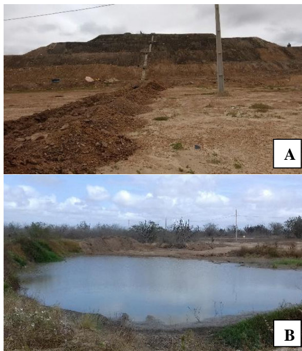
Figura 11 - Drenagem das águas pluviais: A) sistema de drenagem de águas pluviais do ASCG; B) lagoa de acumulação das águas drenadas
