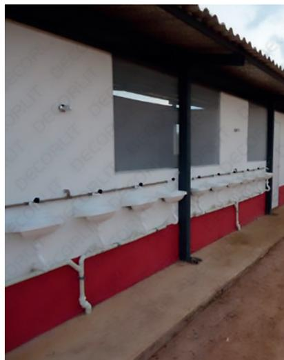
Figura 20 - Painéis PETI utilizados como vedação. Fonte: <http://www.decorlit.com.br/painel-eps-canteiro-obras.html>
