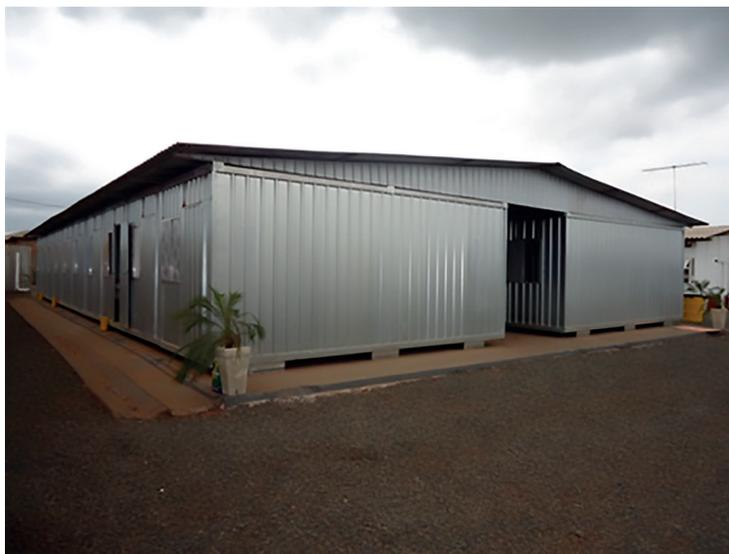
Figura 11 - Construção provisória em aço galvanizado. Fonte: <http://cmcmódulos.com.br>
