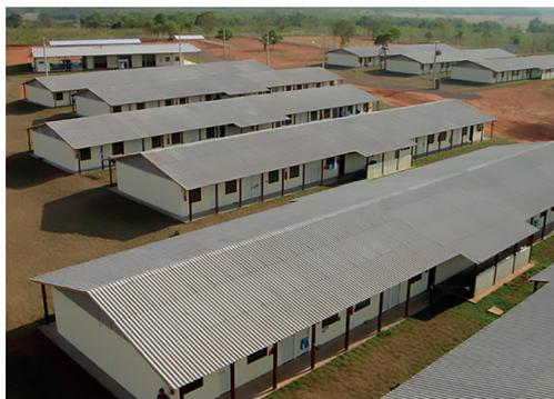
Figura 6 - Vista das construções provisórias em concreto celular.
