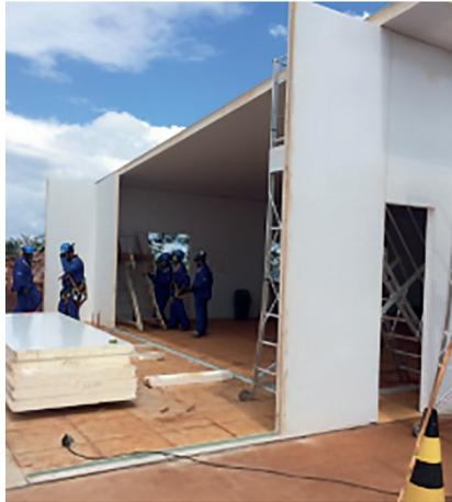
Figura 19 - Montagem de painéis PETI com perfis guia. Fonte: Almeida, 2015.
