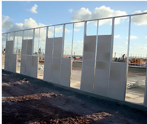
Figura 5 - Montagem da construção provisória em concreto celular.
