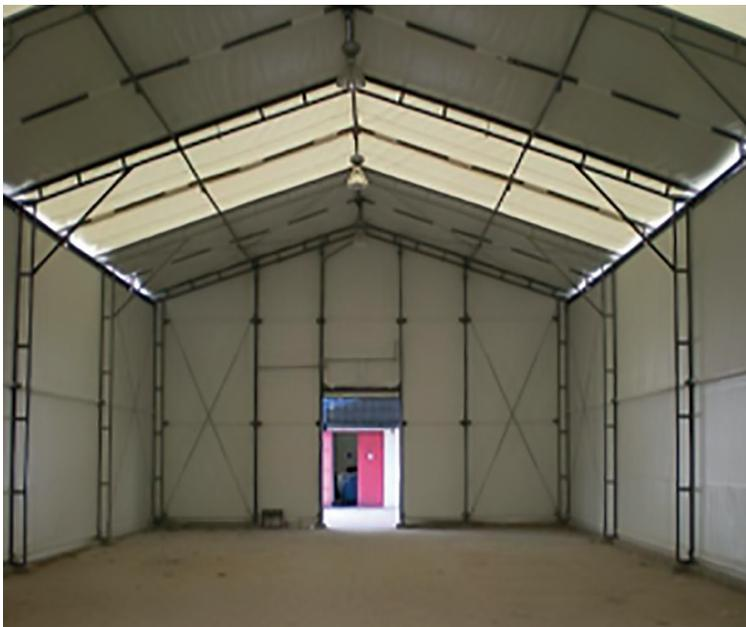
Figura 14- Vista interna de galpão estruturado sem colunas intermediárias.
