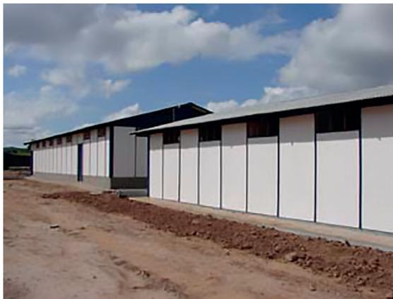
Figura 3 - Instalação provisória pré-fabricada em chapas OSB.
