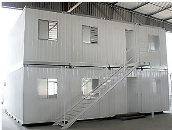
Figura 12 - Construção provisória com dois pavimentos em aço galvanizado.
